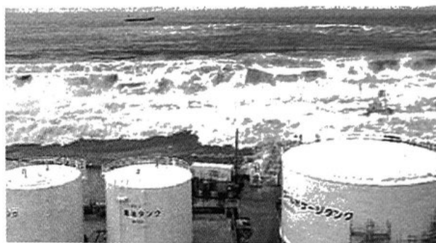
Le tsunami provoque des dégâts sur le site de Fukushima.
