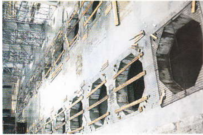
Vue, prise dans un groupe, de la dalle support d'étages avec les alvéoles correspondant à ces étages, avant équipement.
