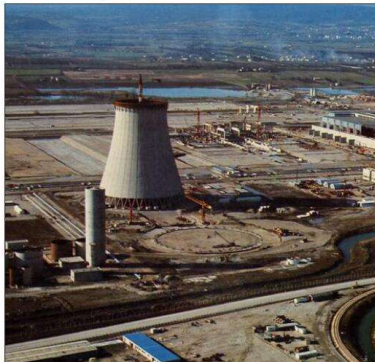
Lors de la construction de l'usine Eurodif. Celle-ci a été inaugurée en 1979. Archives photo Le DL
