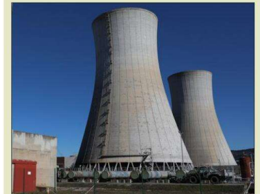
Les deux tours aéroréfrigérantes permettaient d'évacuer la vapeur d'eau issue des circuits de refroidissement de l'usine d'enrichissement de l'uranium par diffusion gazeuse, une technique qui n'est plus du tout utilisée dans la nouvelle unité Georges-Besse II. Photo Le DL/Stéphane MARC
